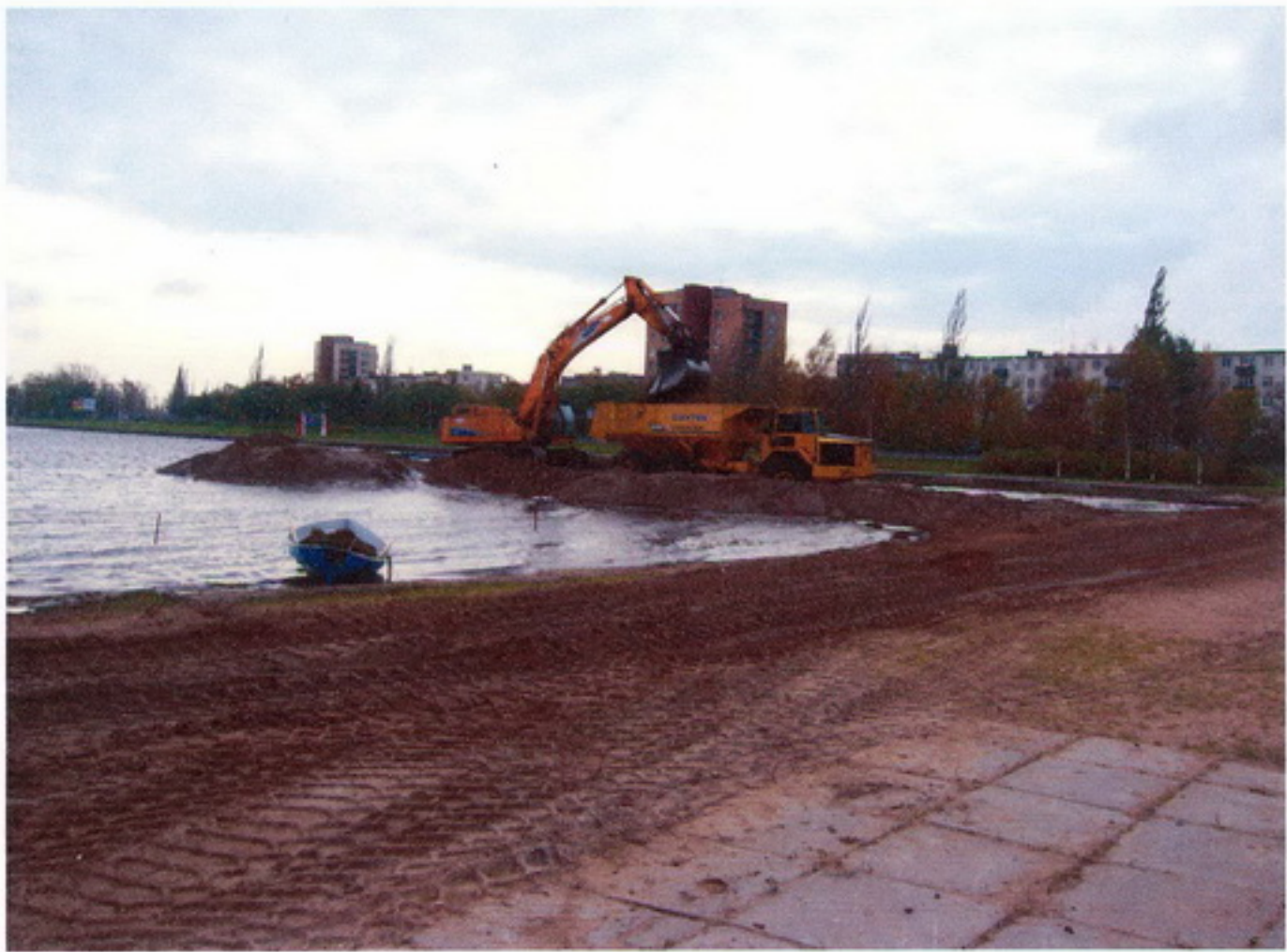
Проходка №2. Работа экскаватора Samsung 450 совместно с сочлененным самосвалом VOLVO.
