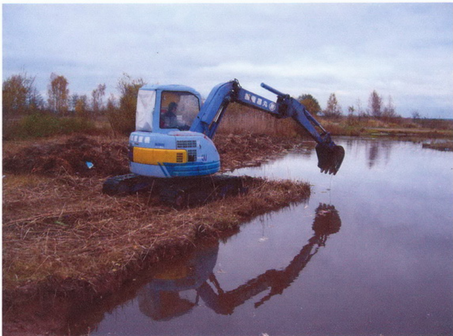
Расчистка существующего водоема.
