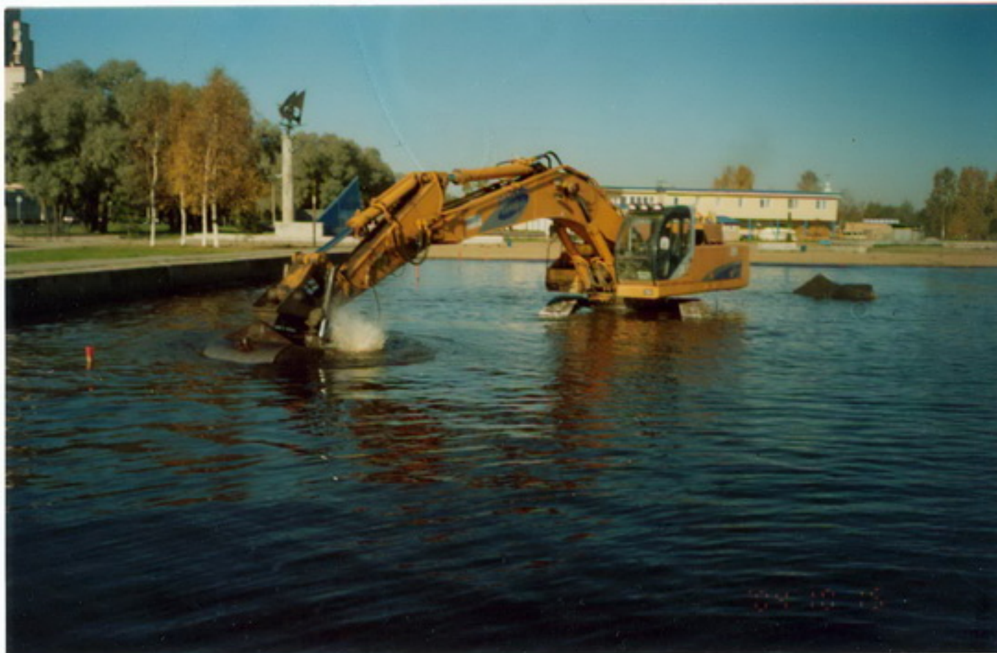
Разработка грунта из-под воды.
