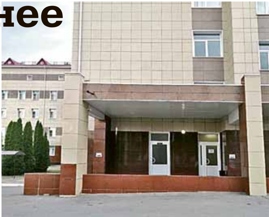
Перед входом в приемное отделение — просторная парковка
