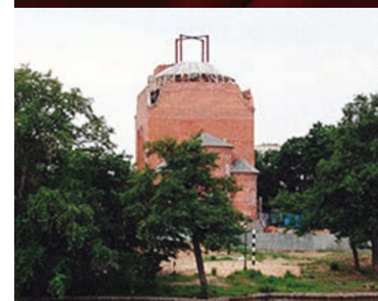
Строительство храма Петра и Павла в городе Сестрорецке
