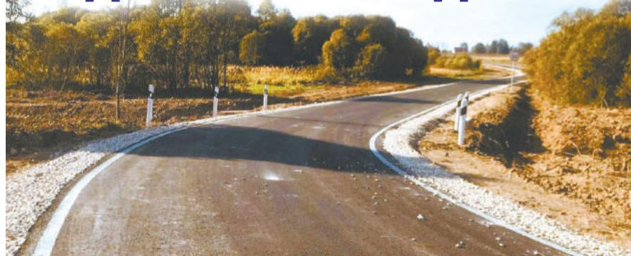
Асфальтовое покрытие уложено на протяжении двух километров до населенного пункта. Также укреплены обочины, выполнен монтаж водопропускных сооружений и системы водоотведения. В проливные дожди влага уже не будет скапливаться на дорожном полотне.
