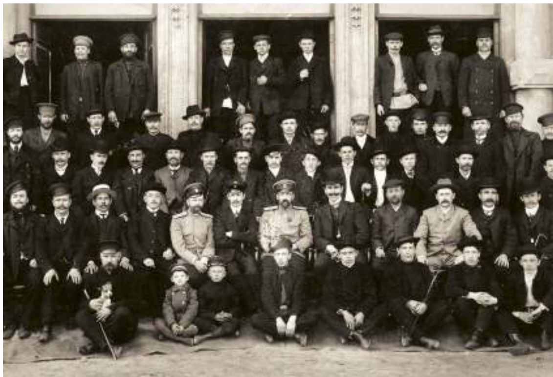
Рабочие центральной электрической станции Обуховского сталелитейного завода.
