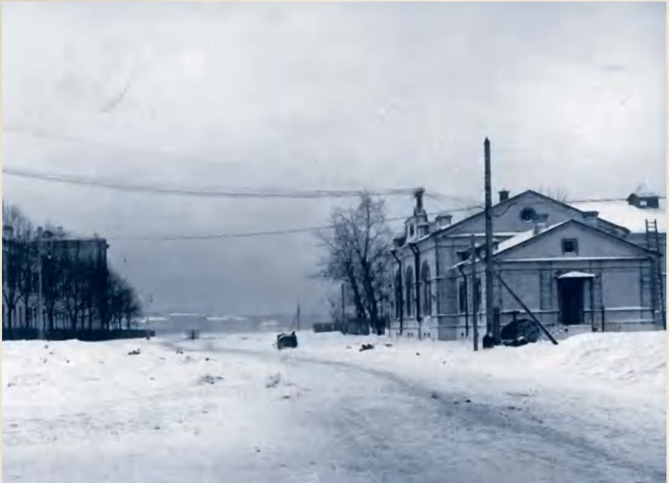
Вид на электростанцию и здание клинического военного госпиталя
