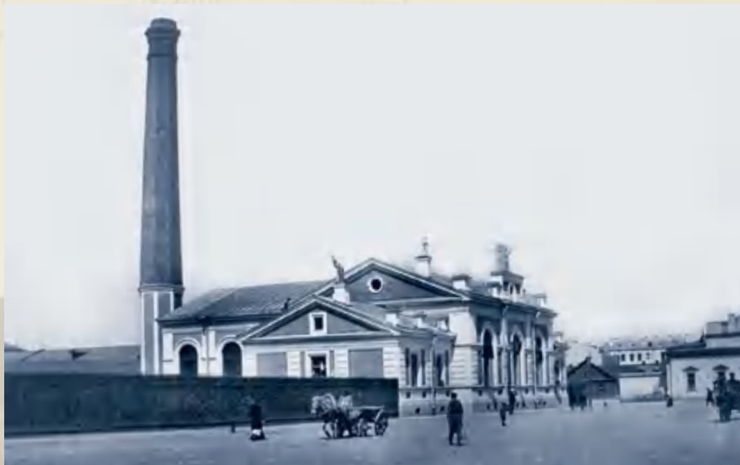
Электростанция Императорской Военно-медицинской академии
