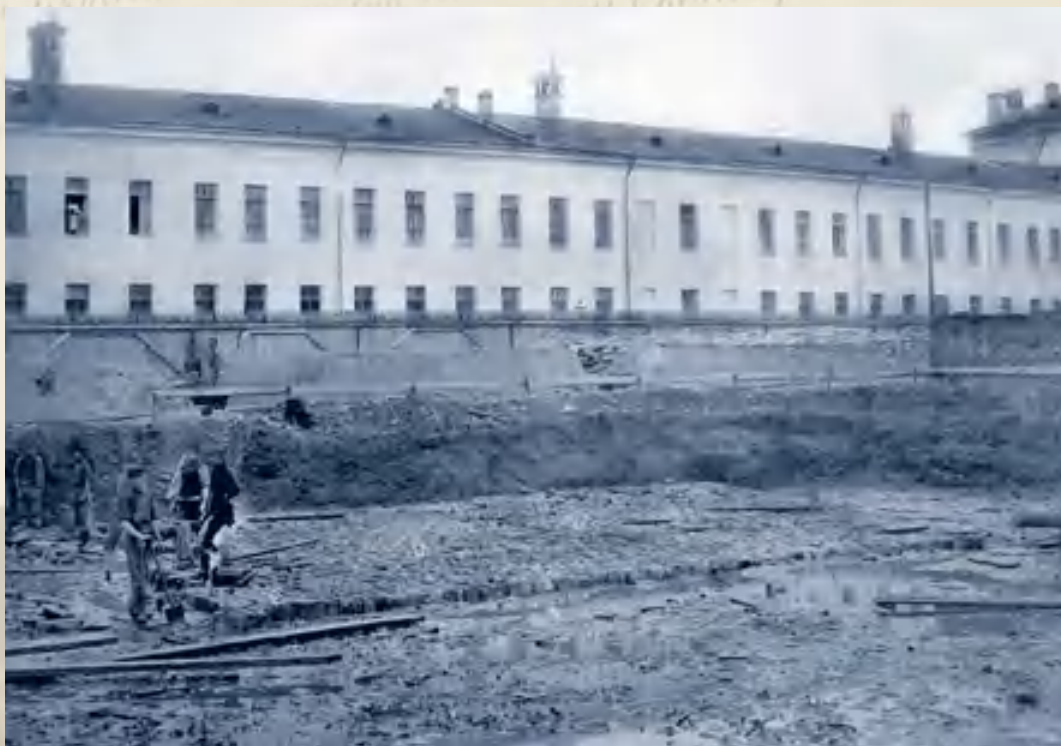
Мощение набережной вдоль клинического военного госпиталя
