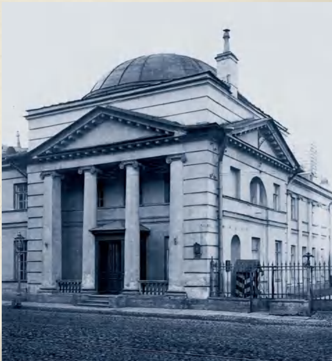
Вид на угловой павильон бокового флигеля Главного здания академии. Вид с Нижегородской улицы. 1914 г.
