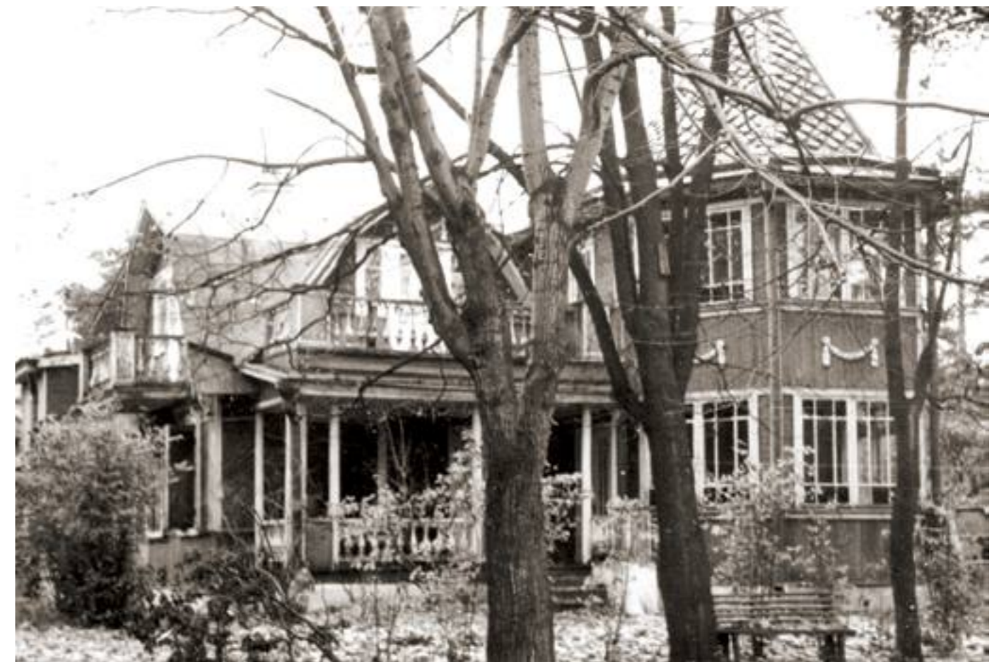
Здание, в котором располагался штаб 3-го СП
