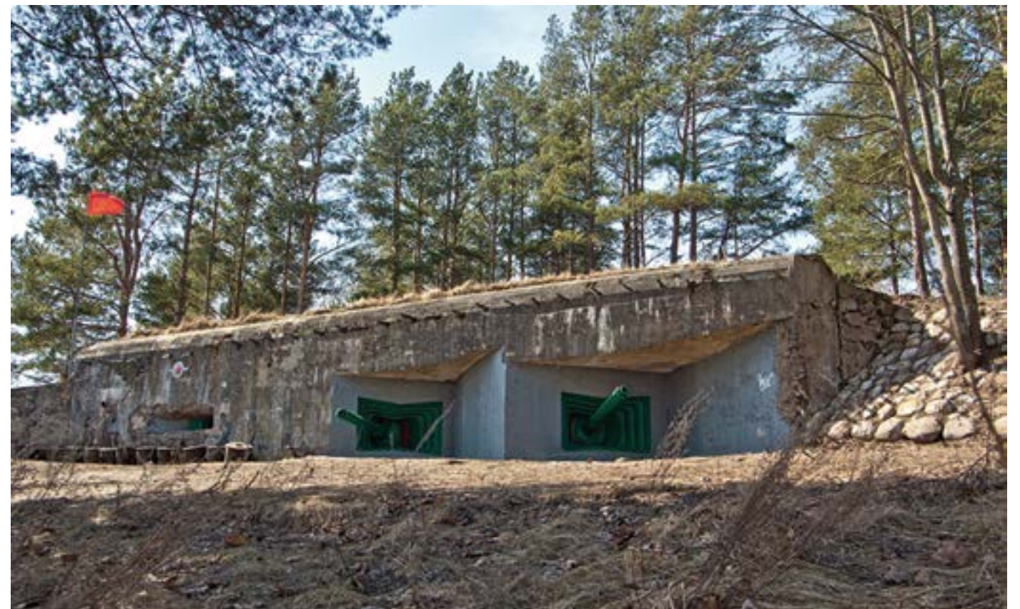
Артиллерийский полукапонир (АПК-1) оснащен двумя орудиями и пулеметом. Год постройки – 1938
